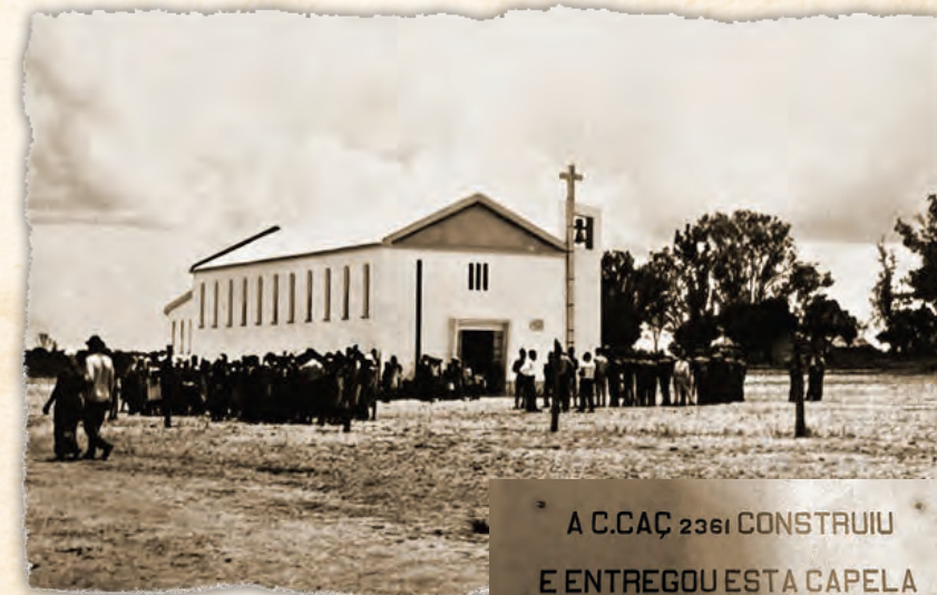
Vista geral da Igreja no dia da inauguração
